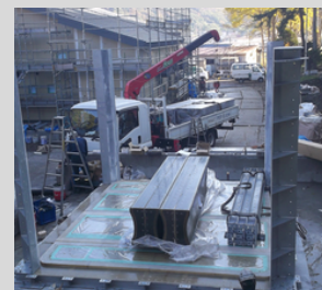
底板コーナ金物設置
