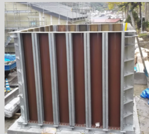
側面パネル設置
