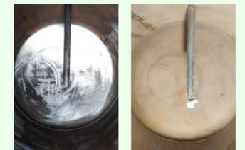
小さい砂状の研磨剤を圧縮空気により噴射し、タンク内面の小さな溝の錆や腐食箇所を取り除きます。
