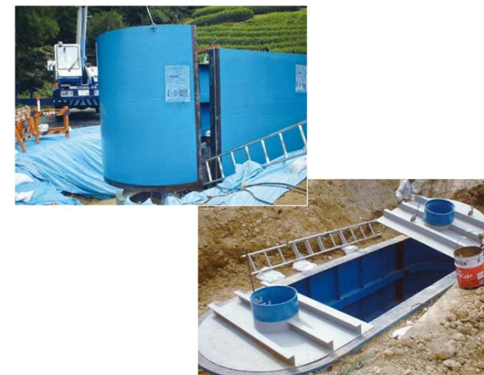
縦円筒タイプと長円筒タイプは施工条件にあわせて選択できます。
