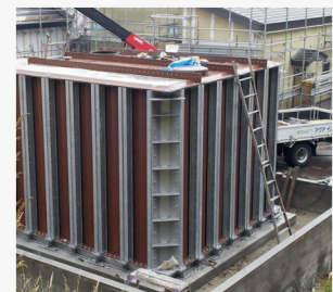
天井パネル設置
