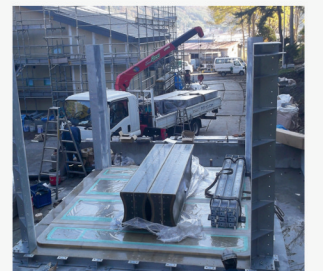
底板コーナ金物設置
