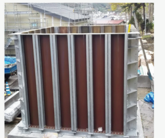
側面パネル設置
